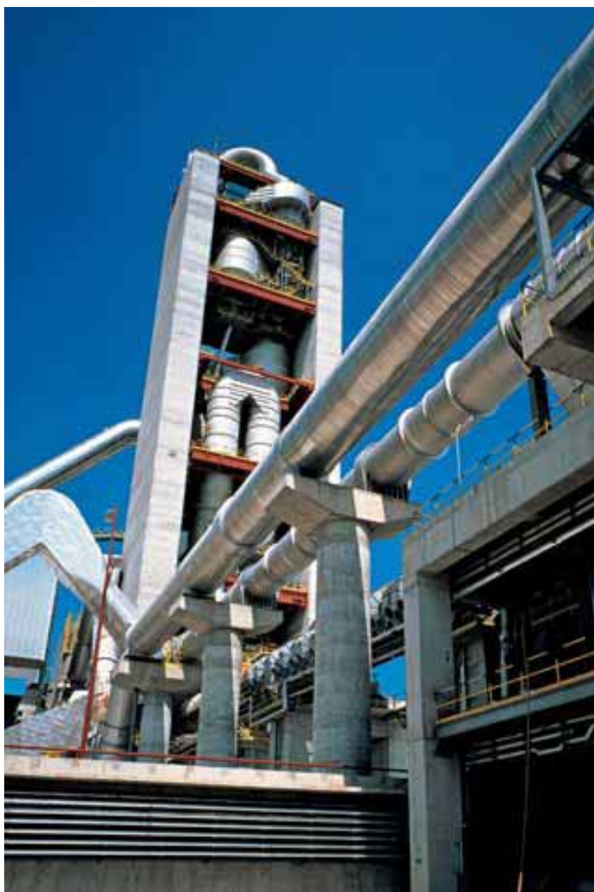
La torre a cicloni del forno 2 di Tepetzingo, Messico The preheater tower of kiln No. 2 at Tepetzingo, Mexico
