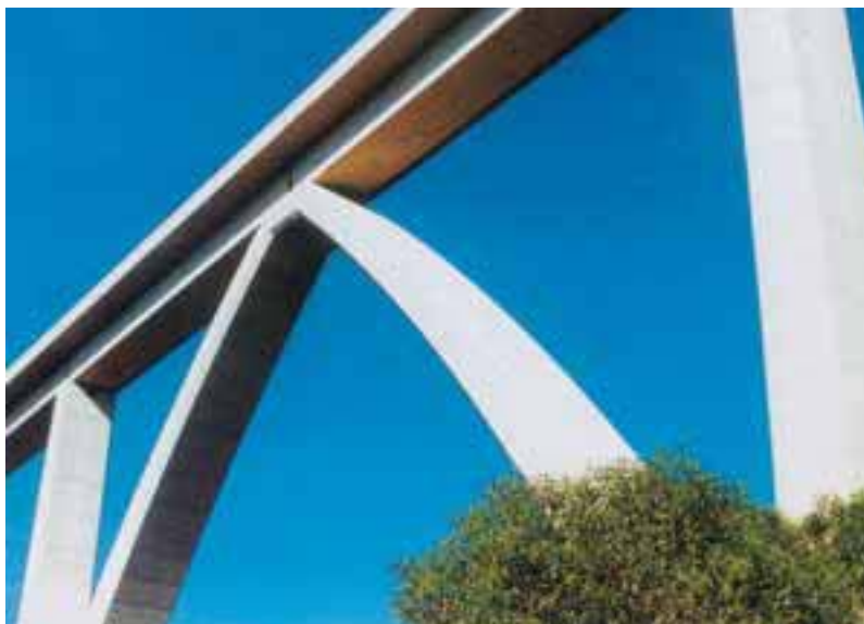
Realizzazione di una struttura in calcestruzzo a vista A structure with an as-cast finish effect concrete
